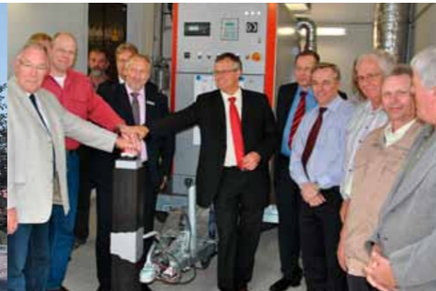
Offizielle Inbetriebnahme des BHKW im Juni 2010.
